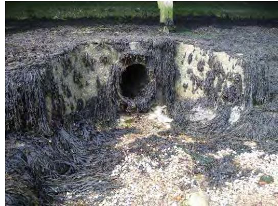
8: Pipe at Hythe Beacon E1:
